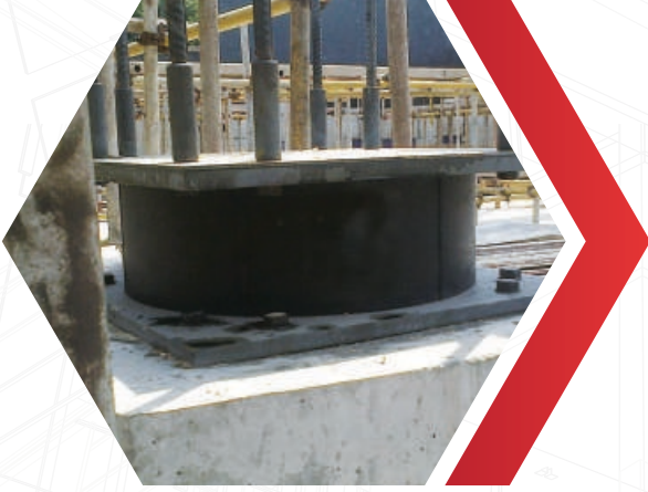
Sismik izolatörün monte edilmesi ve üst takviyelere mesnetlenmesi
