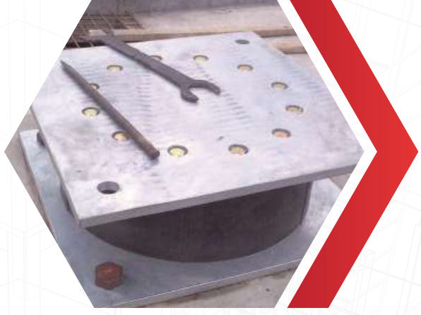
Alt başlık plakasının konumlandırılması,sabitlenmesi ve yeniden kontrol edilmesi
