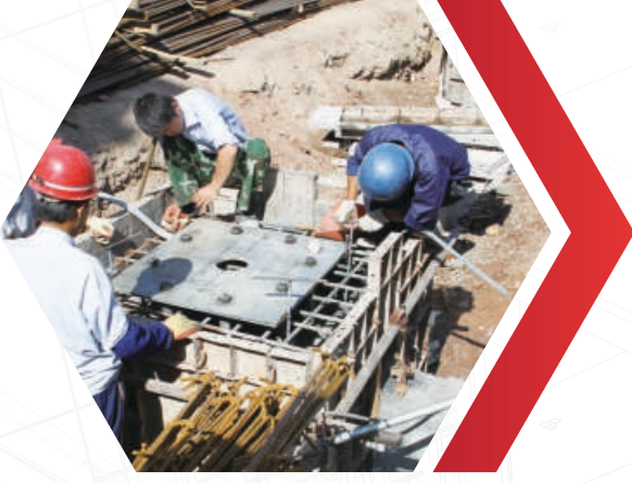
Alt başlık plakasının konumlandırılması,sabitlenmesi ve yeniden kontrol edilmesi
