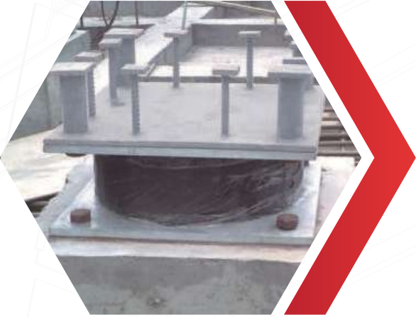
İzolatörlerin montajını takiben inşaatın yapımına devam edilmesi
