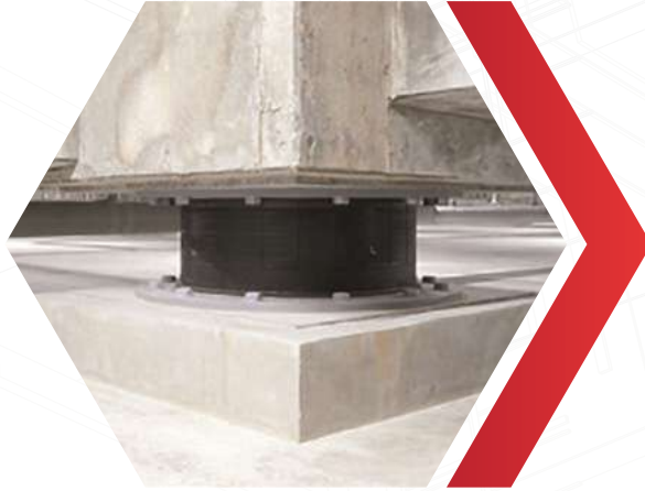
İzolatörlerin montajını takiben inşaatın yapımına devam edilmesi
